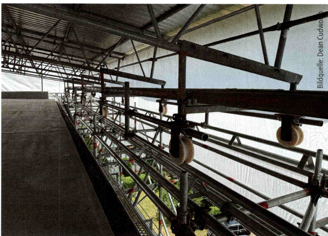
Dank des verwendeten Rollensystems wird das Wetterschutzdach fortlaufend dem Sanierungsfortschritt angepasst.
