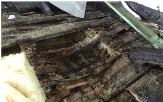
Diese Unterkonstruktion konnte nichts mehr tragen.
