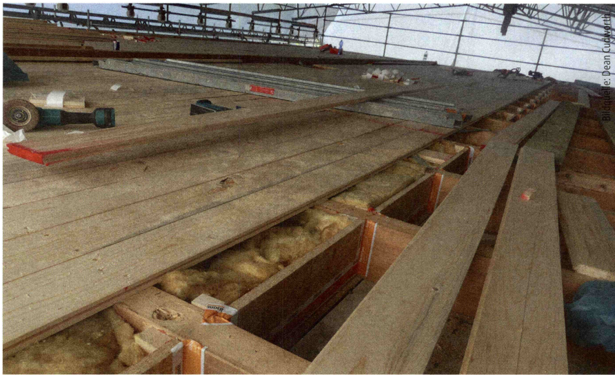
Traufdetail des neuen Dachaufbaus
